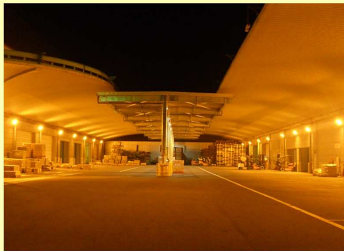
増築工事後の状態
